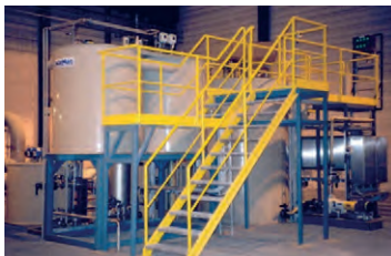
Metalliteollisuuden jätevedenkäsittelylaitteistoa
