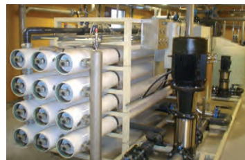
Kunnallista suolanpoistolaitteistoa
